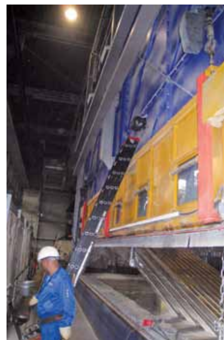
Thermisch zinkbad met sluitbare mantel. (Foto: To Improve)
