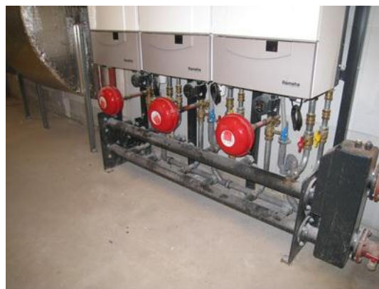
Ongeïsoleerde verdeler CV-ketels
